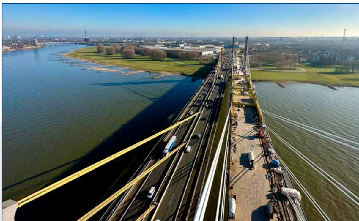
Duisburg. Celková délka mostu je 802 m s rozpětím mezi pylony 380 m ve výšce asi 42 m nad hladinou řeky. The total length of the bridge is 802 m with a span between pylons of 380 m at a height of about 42 m above the river level.
