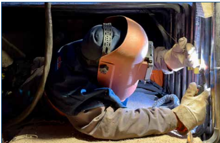
Teplárna Trmice. Opravy svarů, kapacitní výpomoc, výměny součástí kotlů. Repair of welds, capacity assistance, replacement of boiler components.
