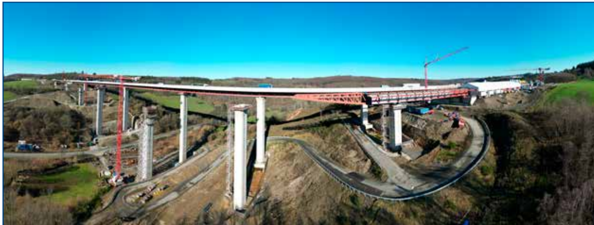
Rinsdorf. Montáž ocelové konstrukce mostu v oblasti Rinsdorf pro společnost ZSB Zwickauer Sonderstahlbau GmbH. Installation of the steel bridge structure in the Rinsdorf area for ZSB Zwickauer Sonderstahlbau GmbH.
