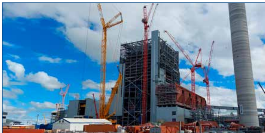
Taurus. Papírna Paso de Los Toros, Uruguay. Montáž ocelové konstrukce a technologie regeneračního kotle o výkonu 9000 tds/d a BFB kotle na biomasu. Installation of the steel structure and technological equipment of the 9000 tds/d regeneration boiler and the BFB biomass boiler.
