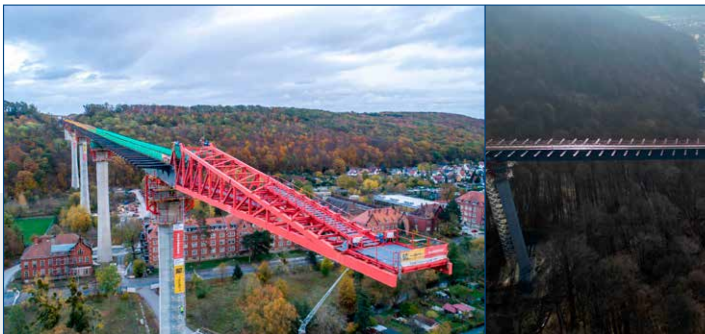
Pirna. Ocelová konstrukce silničního mostu pro společnost Metrostav a.s. München, který vede přes údolí města Pirny (nad budovami, běžeckým hřištěm, řekou, cestou, lesem apod.). Montáž konstrukce mostu probíhá systémem postupného výsunu (9 taktů) pomocí ocelových lan, od jedné opěry postupně ke druhé. Objekt je součástí obchvatu Pirny B172.
