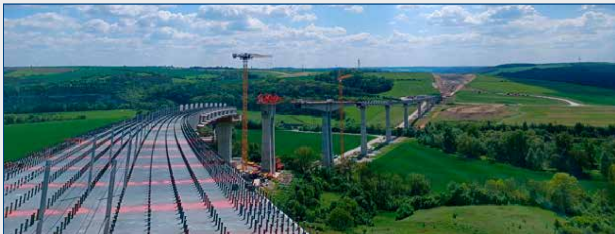
Bad Kösen. 4.600 tun hlavní nosné ocelové konstrukce mostu a 400 tun pomocných konstrukcí. Most byl montován výsuvy z obou stran přes údolí a řeku Saale. 4,600 tonnes of the main steel structure of the bridge and 400 tonnes of auxiliary structures. The bridge was assembled by protruding from both sides over the valley and the Saale River.
