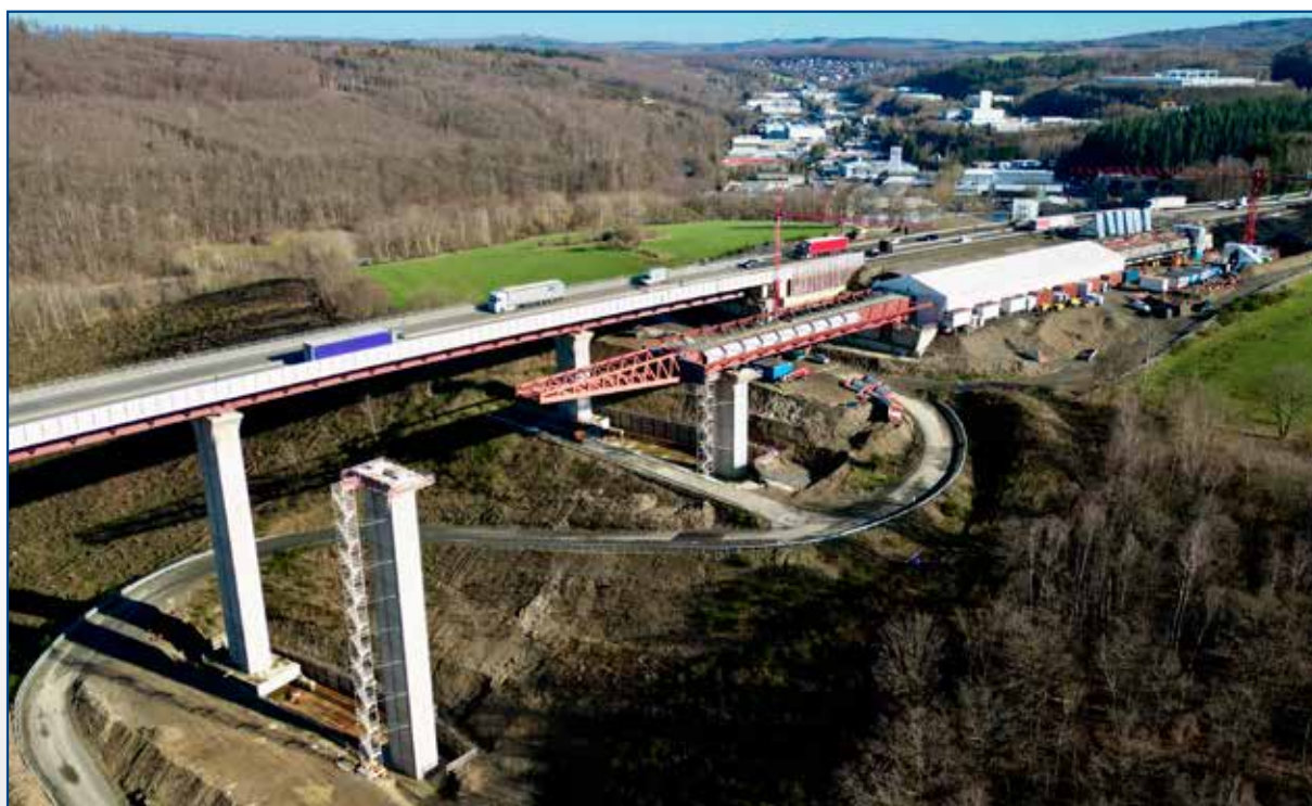
Rinsdorf. Montáž ocelové konstrukce mostu. Assembly of the steel bridge structure.
