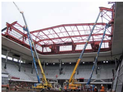
demontáž původní střechy
